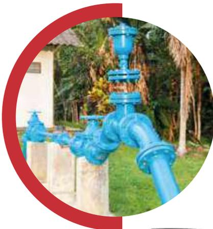
La válvula expulsora de aire es útil para evacuar la presencia así reducir el ruido o turbulencia que genera.
