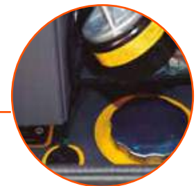
TANQUE DIESEL Capacidad 45 L
